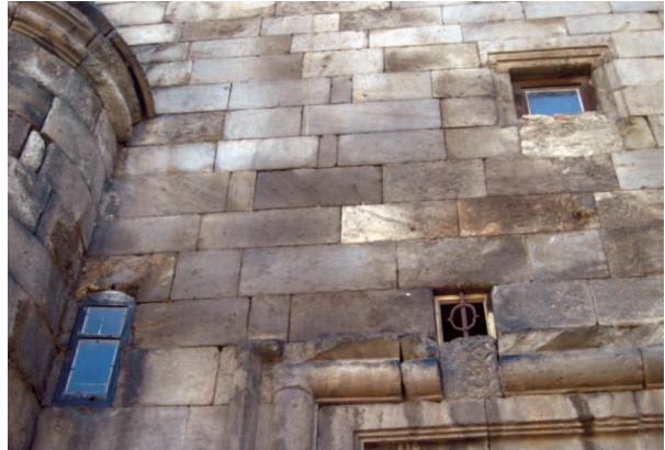
Fotoğraf 19. Kuzeydoğu cephede alt ve üst kata ait pencerelerin bugünkü durumu.
