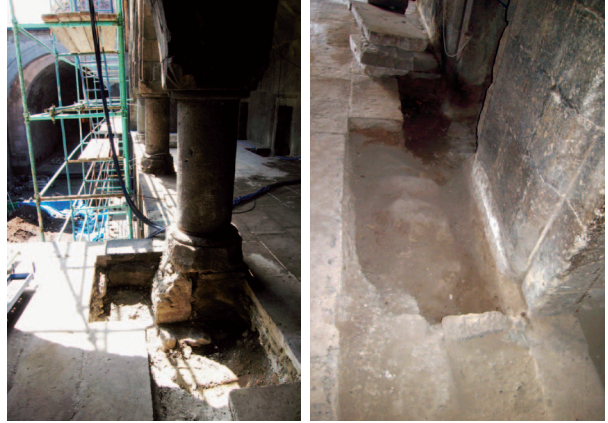
Fotoğraf 4. 1. katta eski döşeme üzerine eklenmiş beton tabliye ve kesme taş döşeme.
